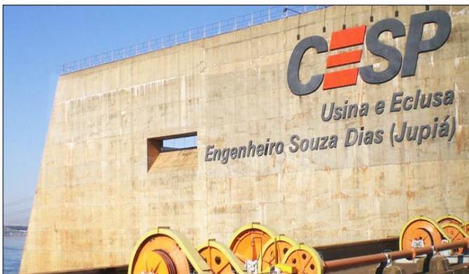
A Usina Hidrelétrica foi construída com tecnologia inteiramente brasileira e concluída em 1974. Possui 14 unidades geradoras com turbinas Kaplan com potência instalada de 1.551,2 MW e dois grupos de turbina-gerador, para
